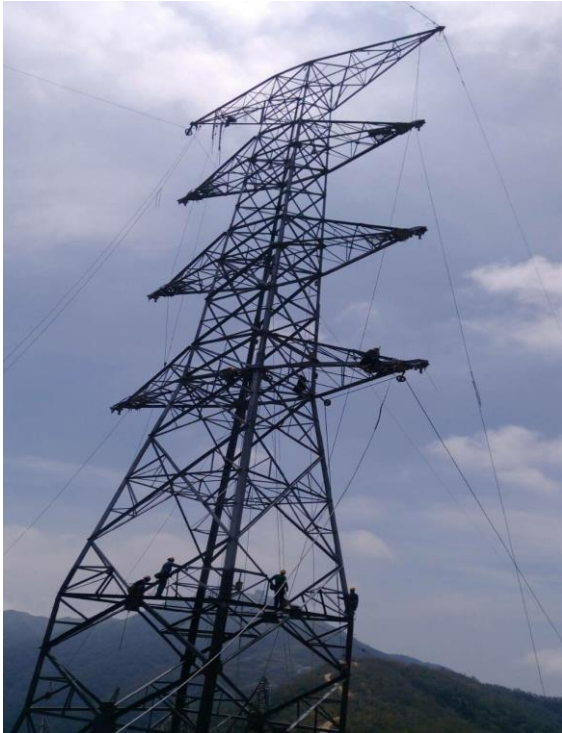
8月9日完成電塔組裝
