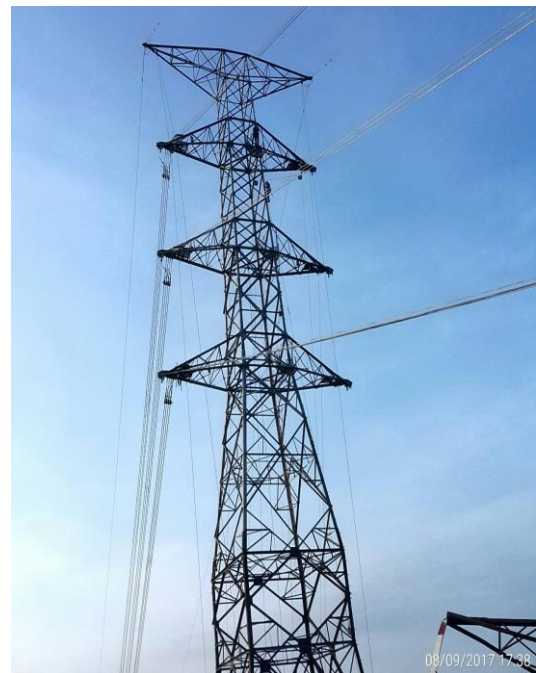
8月9日第一回線移線完成
