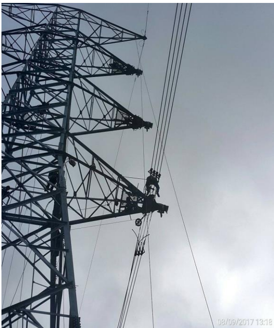
8月9日第一回線移線中
